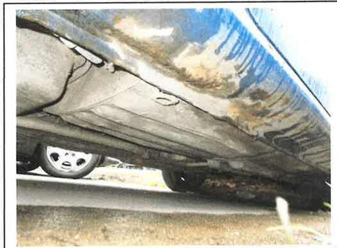
Fot.14. Uszkodzony próg P
